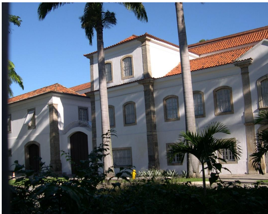
Figura 1) Fachada do Museu Histórico Nacional do Rio de Janeiro (MHN) e da chamada “Casa do Trem” (foto MHN).
